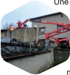
Une entreprise est intervenue pour réaliser des travaux de sécurisation d'une partie du bâtiment communal. Les ouvriers ont démonté la toiture de la grange et ont raccourci un mur qui menaçait de tomber.
